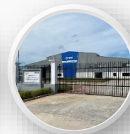
Производственная база в Камбодже
